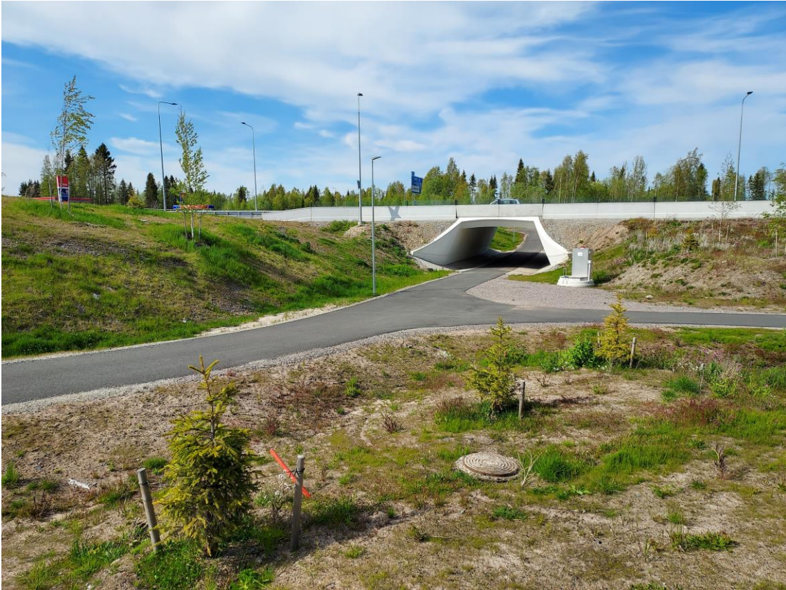
Kuva 3. Suunnittelualueetta rajaa pohjoisessa Vt 4 meluvalleineen, -istutuksineen ja -aitoineen.
